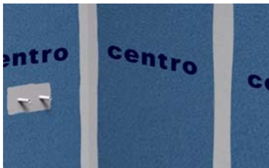
13. Försegla alla golv- och väggvinklar och hörn med Centro TM#10. För ökad trygghet kan även hela väggen rollas med Centro TM#10. Plattsättning kan utföras efter ca 12 timmar. Observera att torktiden kan variera beroende på temperatur och luftfuktighet.
